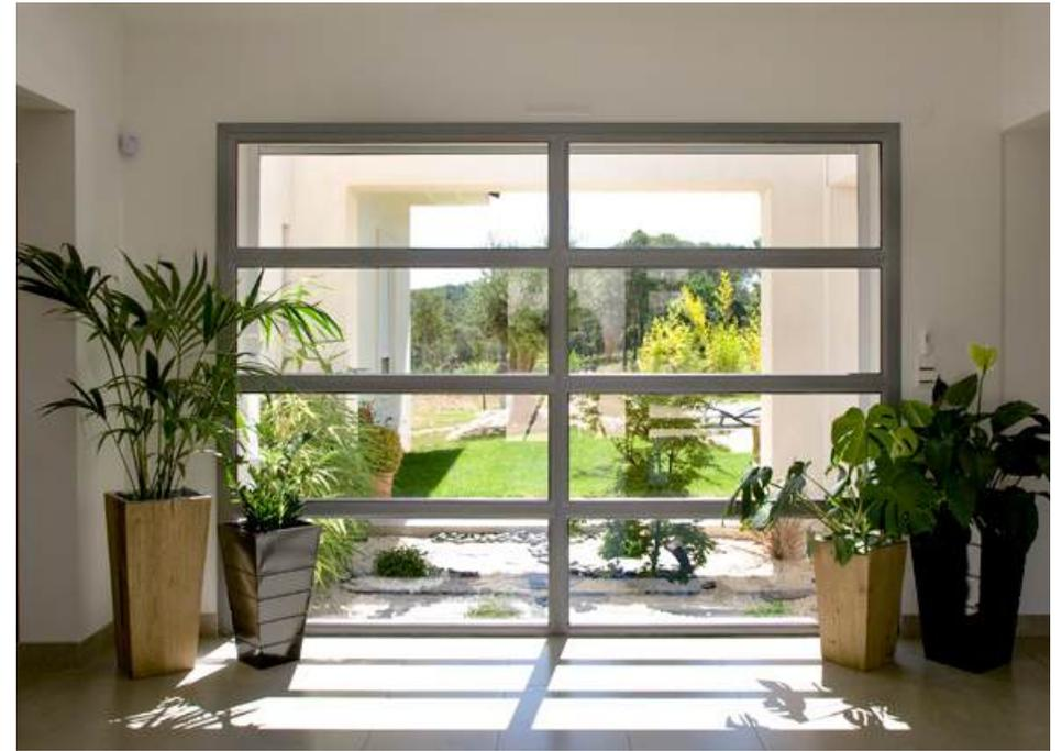
Un large châssis fixe en Alu, avec des traverses horizontales et verticales invite la lumière dans ce hall d'entrée avec vue sur un jardin zen...
